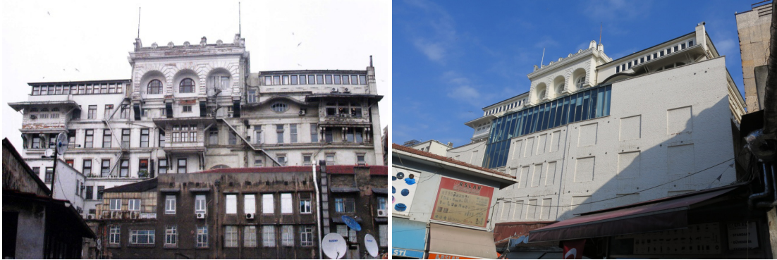
Fotoğraf: 23 Yapının Güney Cephesinin Hırdavatçılar Çarşısından Görünümü (Restorasyondan Önceki Bir Tarihte)
