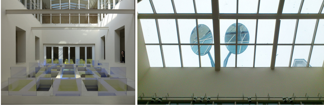
Fotoğraf: 27 Kat 3’de Yer Alan Şeffaf Lamine Cam Panel Düzenegi E. Nurçin Kara (18 Şubat 2017)
